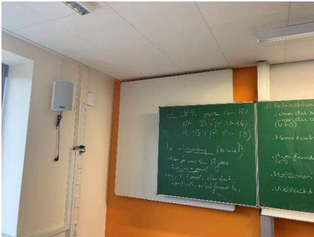
Der EAP245 ermöglicht WLAN für das Klassenzimmer
