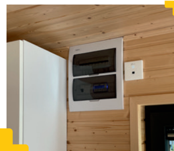
Punkty dostępowe EAP115-Wall zostały zamontowane w każdym z domków przy skrzynce z bezpiecznikami. Zapewniają dostęp WiFi w obrębie domu oraz przed nim.
