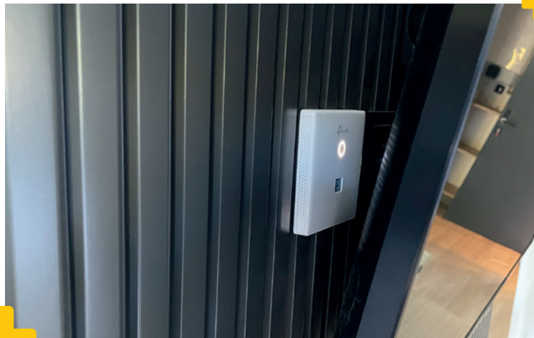
Punkty dostępowe EAP115-Wall zostały zamontowane w puszkach elektrycznych bezpośrednio za telewizorami.
