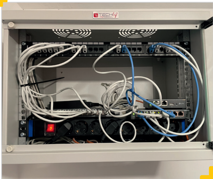
Jednolita konfiguracja wszystkich punktów dostępowych możliwa była dzięki zastosowaniu kontrolera sieci – Omada OC200.
