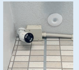
各フロアに設置済みのバレット型「VIGI C345」
